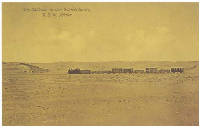
Blick auf die Südbahn, die in das Landesinnere von Deutsch-Südwestafrika führte.
