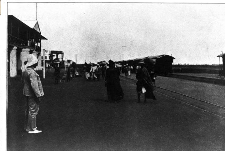
Der Bahnhof in Lome kurz nach Ankunft eines Betriebszugs der Küstenbahn.
